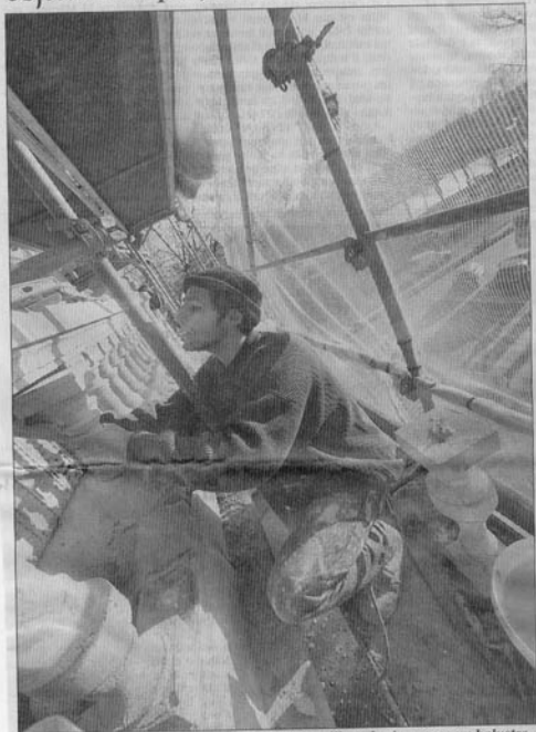
Mardi 14 décembre. J-18 : le tailleur de pierre pose un balustre...
